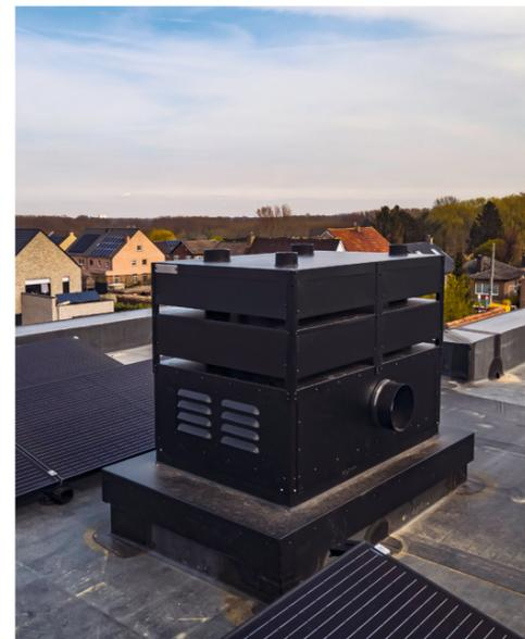
Des constructions de passage de toiture multifonctionnelles qui combinent diverses options d'alimentation et d'évacuation d'air dans un seul système:
