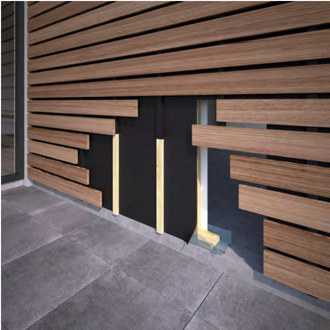
Multivap UV verwerkt in de gevel.
