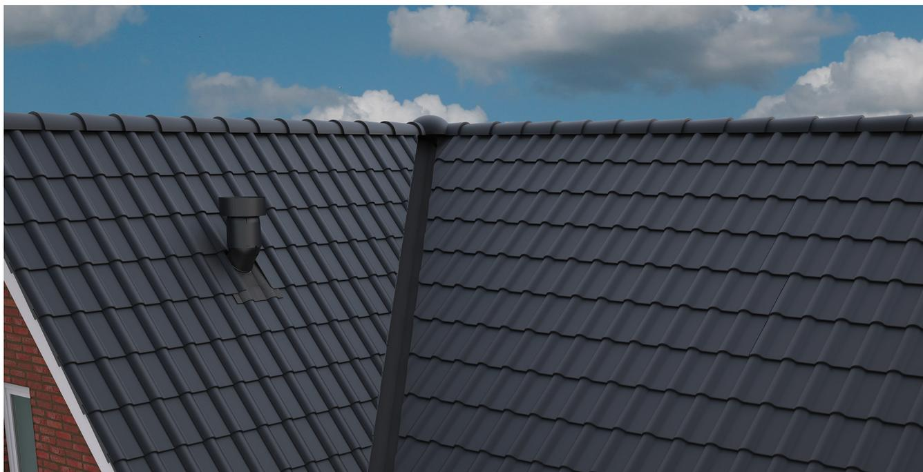
Une large gamme de passages de toiture et de passages muraux de haute qualité pour la ventilation mécanique, l'évacuation de hottes, l'aération d'égouts ou des combinaisons de ces éléments. Selon la version choisie, les passages de toiture peuvent être installés sur des toits en pente ou des toits plats au moyen d'une tuile ou plaque à coller adaptée. La plupart des passages de toiture sont fournis avec des accessoires assortis, tels qu'un collier de fixation sous toiture et une genouillère.
