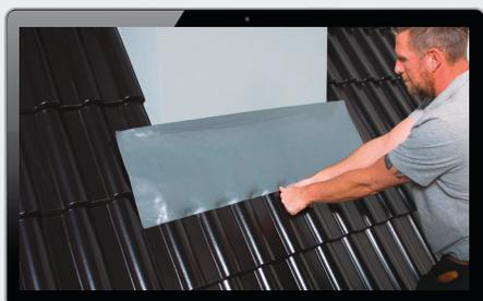
5. Il suffit d'enfoncer Ubiflex Finio dans le pan de toit avec les mains
